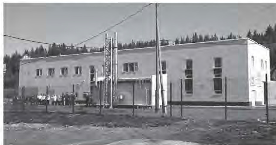
Очистные сооружения в Верхних Сергах.
