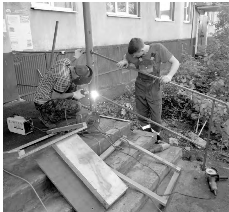
Ремонт входа на ул. Союзной, 57
